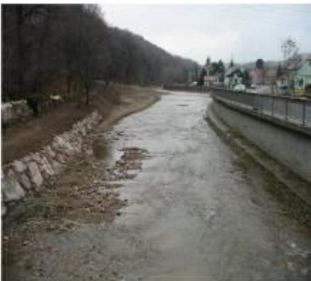
Bauzustand – Blick stromabwärts - Industriebrache zurückgebaut – Gewässerbett erweitert – links Geländeabsenkung erkennbar
