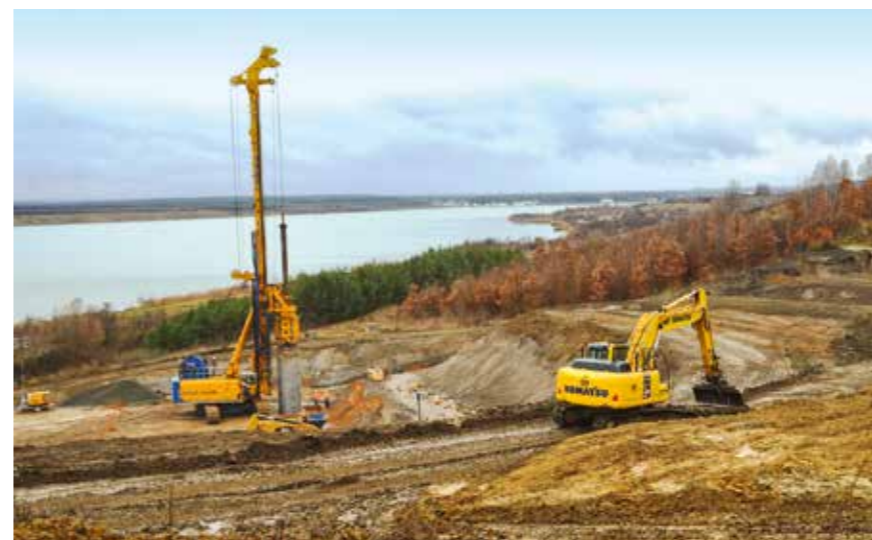
Bodenverbesserung am Hainer See 2016
