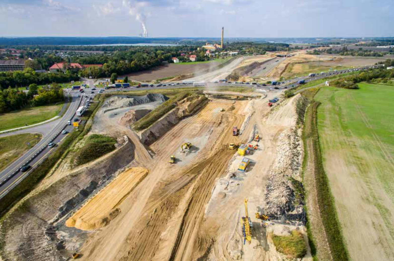
Provisorium am südlichen Bauanfang 2015
