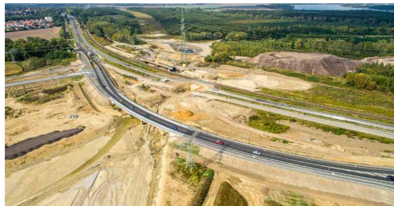
Nördliches Bauende Abschnitt 5.1 Sommer 2017
