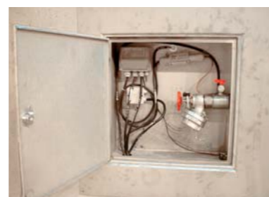
Löschwasserentnahmestelle
