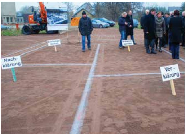
Baubeginn Gruppenkläranlage Mutzschen (Versorgungsverband Grimma Geithain)
