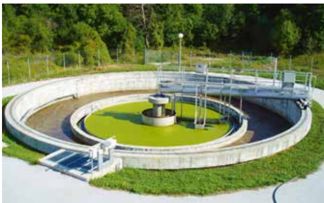
Kommunale Kläranlage: Belebungsbecken
